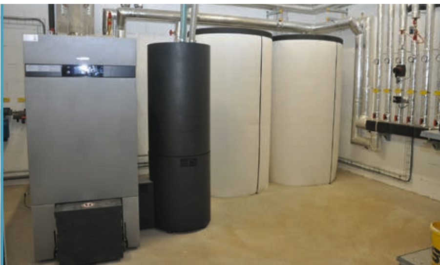
Diese 80-KW-Pellet-Heizungsanlage wurde bei der Brörmann GmbH, Brannenheide, installiert.
