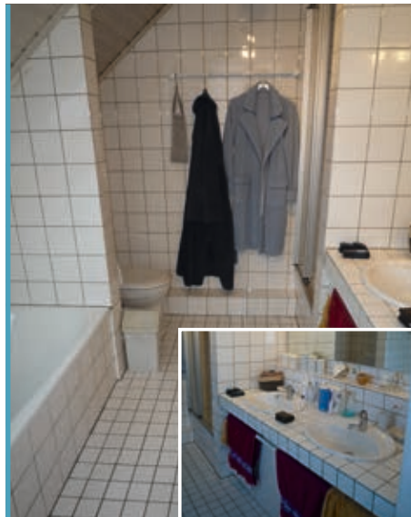
Das Bad der Eheleute Kahlke aus dem südl. Landkreis nach erfolgreicher Sanierung (vorher/nachher).
